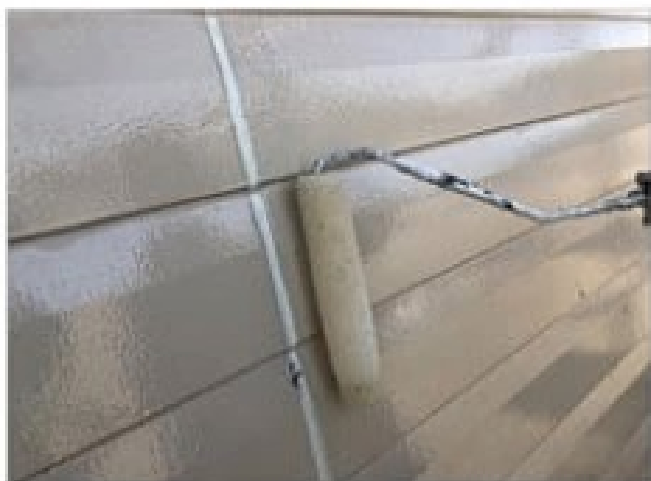
外壁下塗りプライマー2回目塗装中
