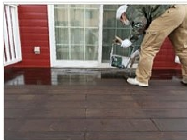
ウッドデッキ上塗り塗装中
