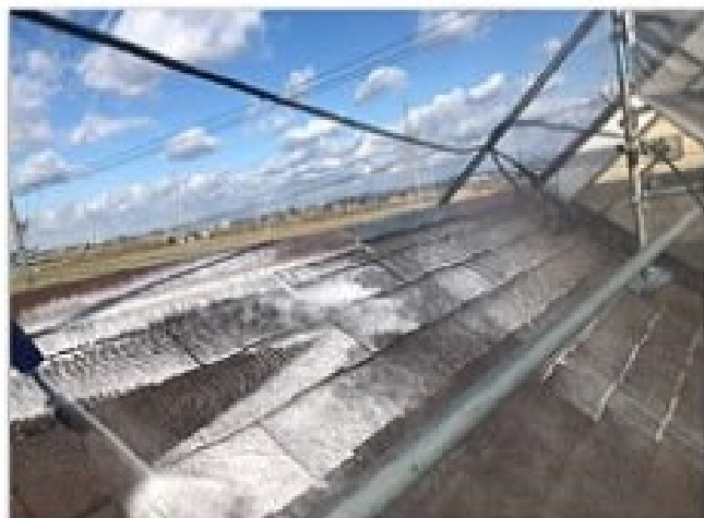
屋根バイオ洗浄材塗布中
