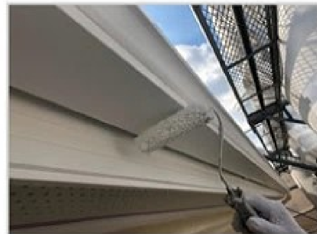
樋上塗りフッ素塗装中
