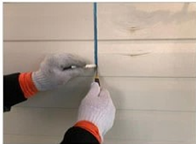
目地部コーキング撤去中
