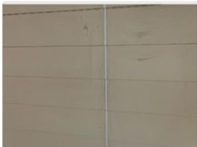
目地部コーキング処理後
