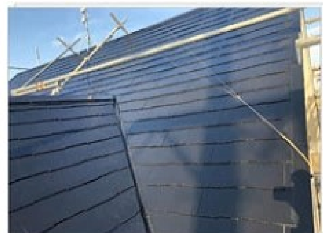
屋根中塗りラジカル塗装後
