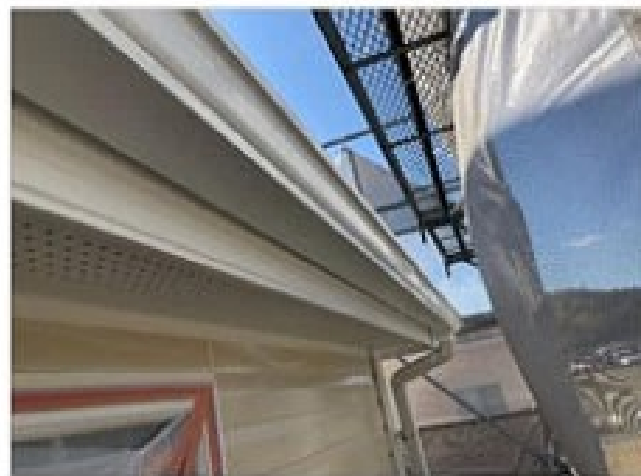
樋下塗りフッ素塗装後
