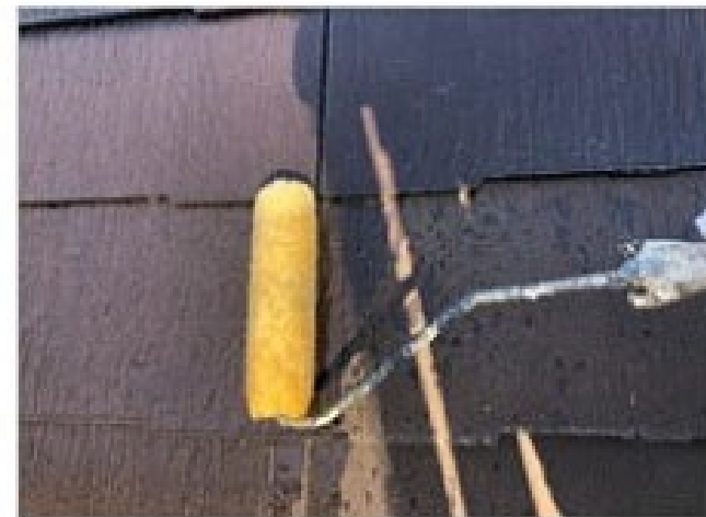
屋根エポキシプライマー塗装中
