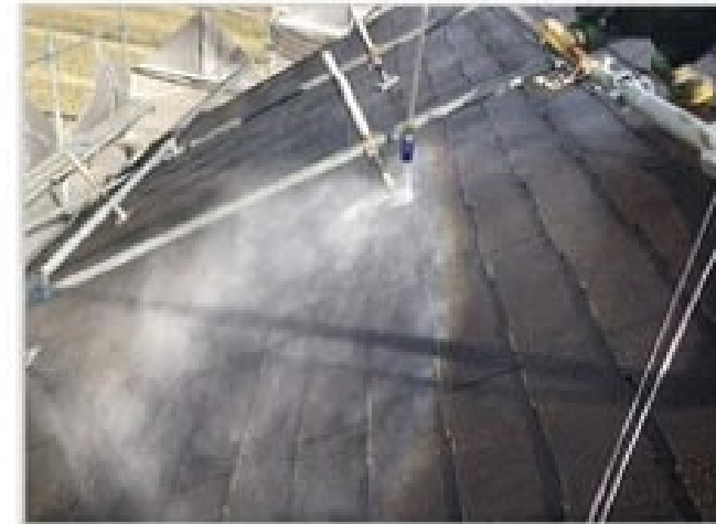
屋根高圧洗浄作業中
