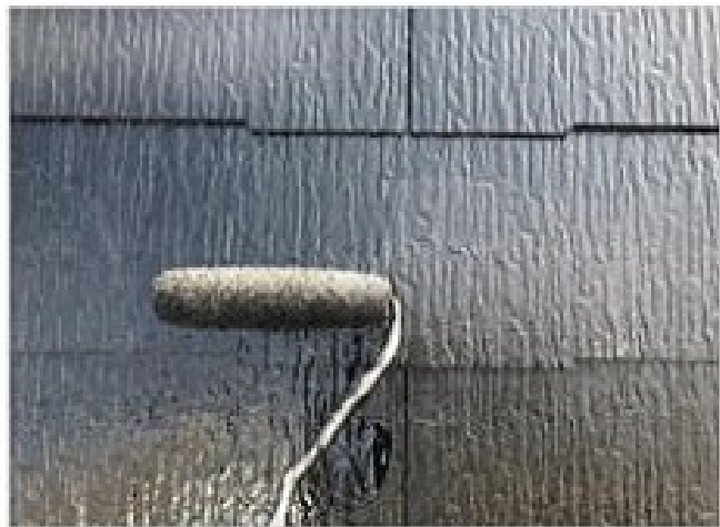
屋根上塗りラジカル塗装中
