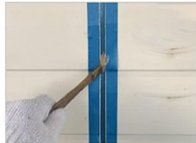
目地部密着プライマー塗布中
