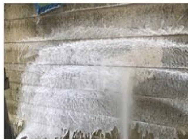
外壁バイオ洗浄材塗布中
