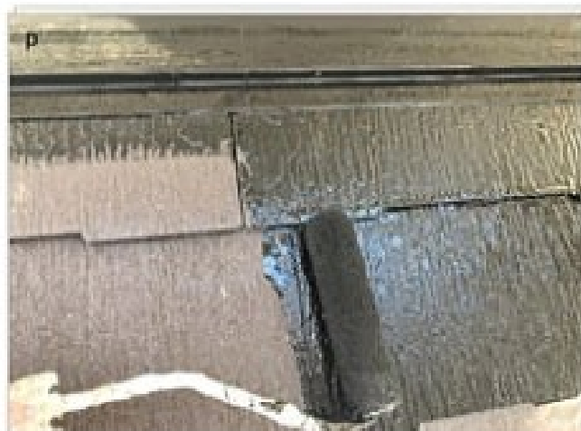
屋根中塗りラジカル塗装中
