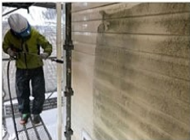
外壁高圧洗浄作業中
