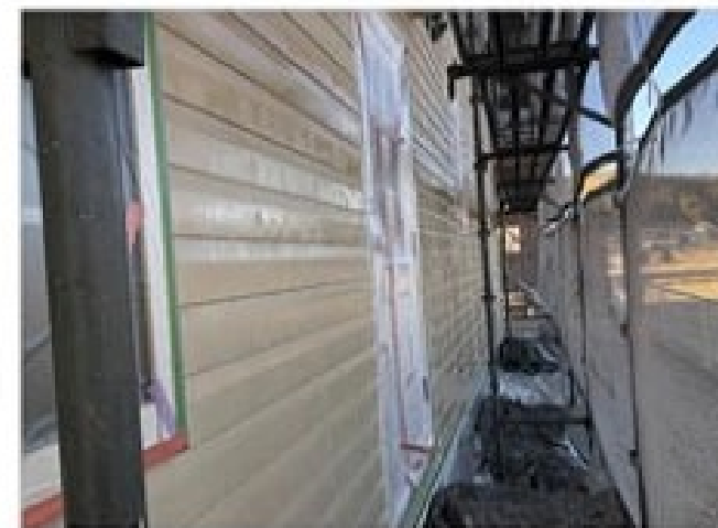
外壁下塗リエポキシプライマー塗装後
