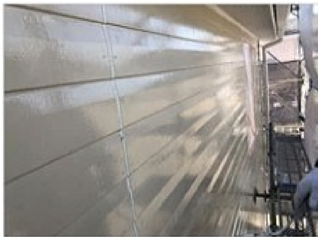
外壁下塗りプライマー2回目塗装後
