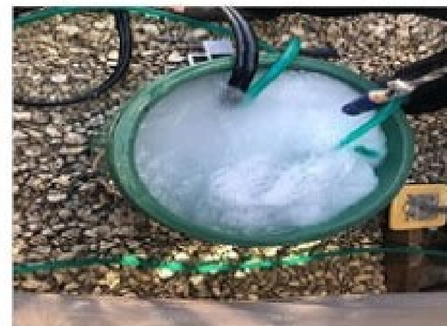
高圧洗浄バイオ洗浄材挿入後
