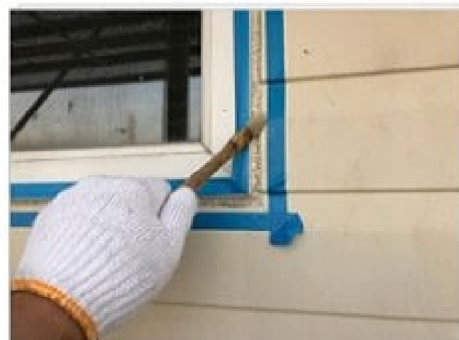
サッシコーキング密着プライマー塗布中
