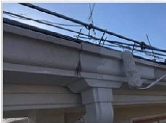
樋下塗りフッ素塗装中
