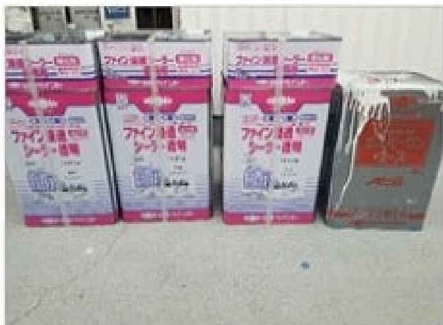
材料検収 下塗り・日本ペイントファイン浸透性シーラー
