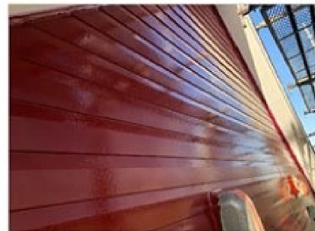
外壁上塗りフッ素塗装後
