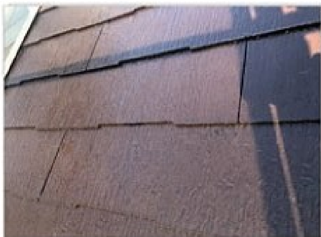
屋根エポキシプライマー塗装後
