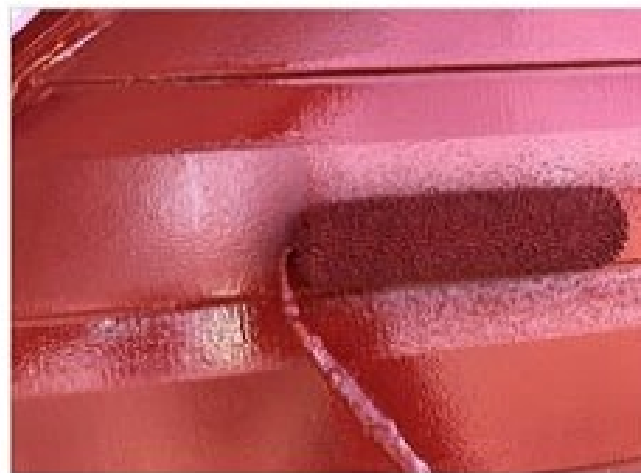
外壁上塗りフッ素塗装中
