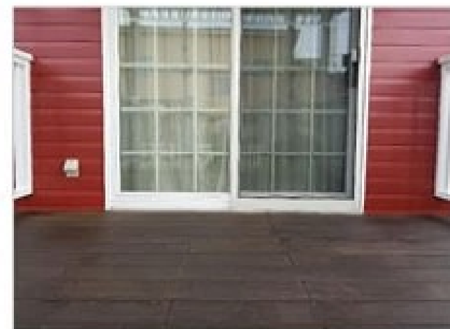
ウッドデッキチェスナット下塗り塗装後
