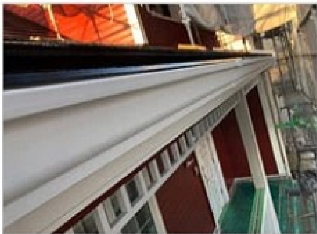
樋上塗りフッ素塗装後
