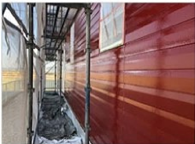
外壁中塗りフッ素塗装後
