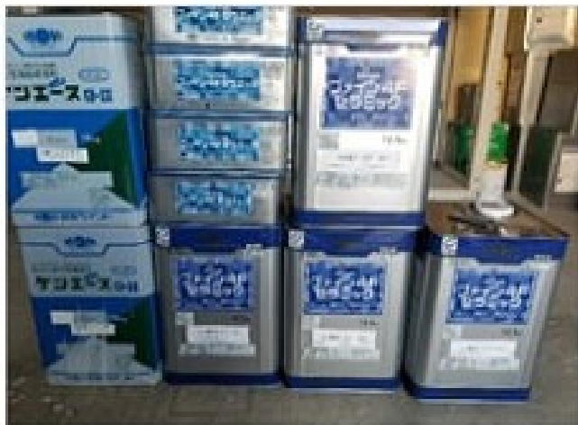
材料検収 軒天・日本ペイントケンエース
