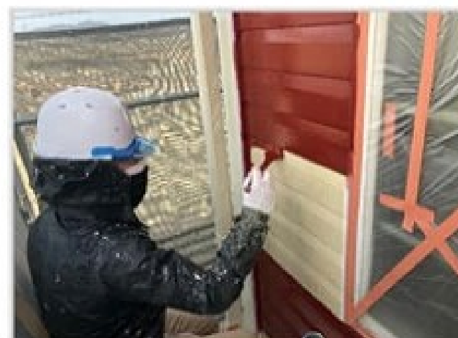
外壁中塗りフッ素塗装中
